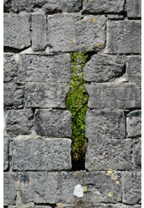
Bouvignes, porte Laval, fente de tir reconstituée pour coulevrine à main. Photo D. Belayew, 2021
