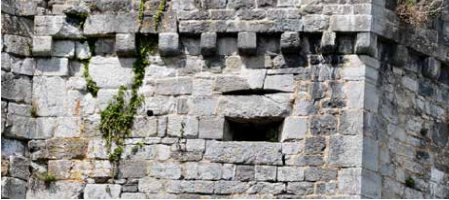
Bouvignes, fortification de Crèvecœur, canonniers pour coulevrine (1460). Photo D. Belayew, 2021
